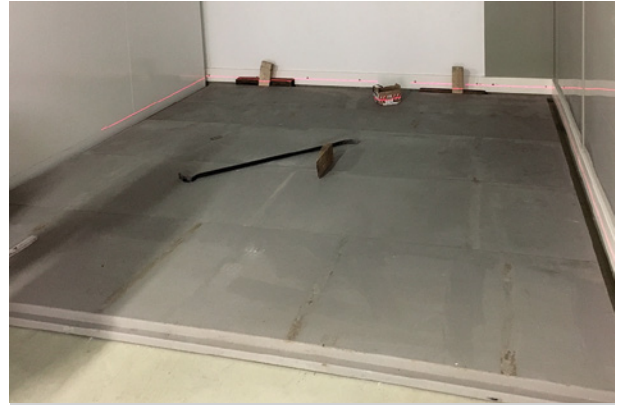
Verlegung des Modulraum-Bodens
