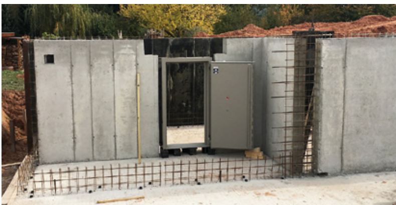
Einbau der Wertschutzraumtür (hier mit Tagesgittertür) während der Bauphase
