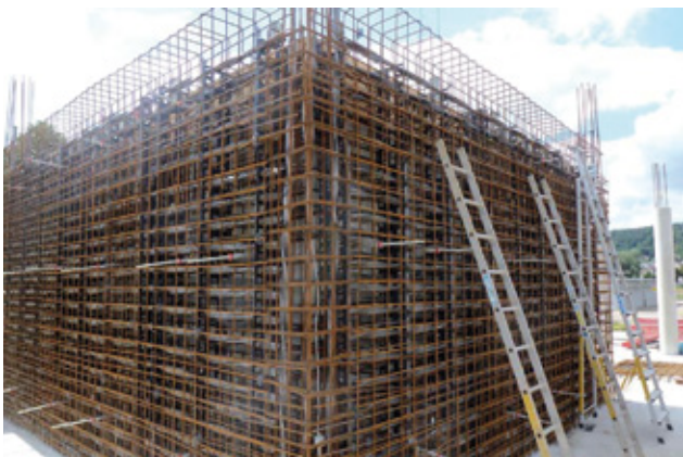
Montage der Sicherheitsarmierung in der Wand
