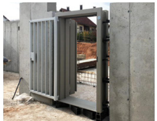
Montageansicht mit Öffnung für Wertschutzraumtür
